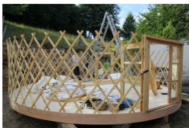
Dřevěná konstrukce bez střechy
