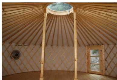
Dřevěná konstrukce s folií
