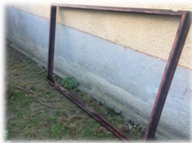
Obr. 7: Rám, v němž byly topné panely, které už dosloužily. Foto: Autor
