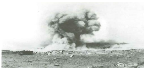
Obr. 9 a 10: Clonový odstřel v etáži A výkopiště horní nádrže
