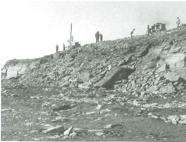
Obr. 8: Nabíjení vrtů pro clonové odstřely v etáži A výkopiště
