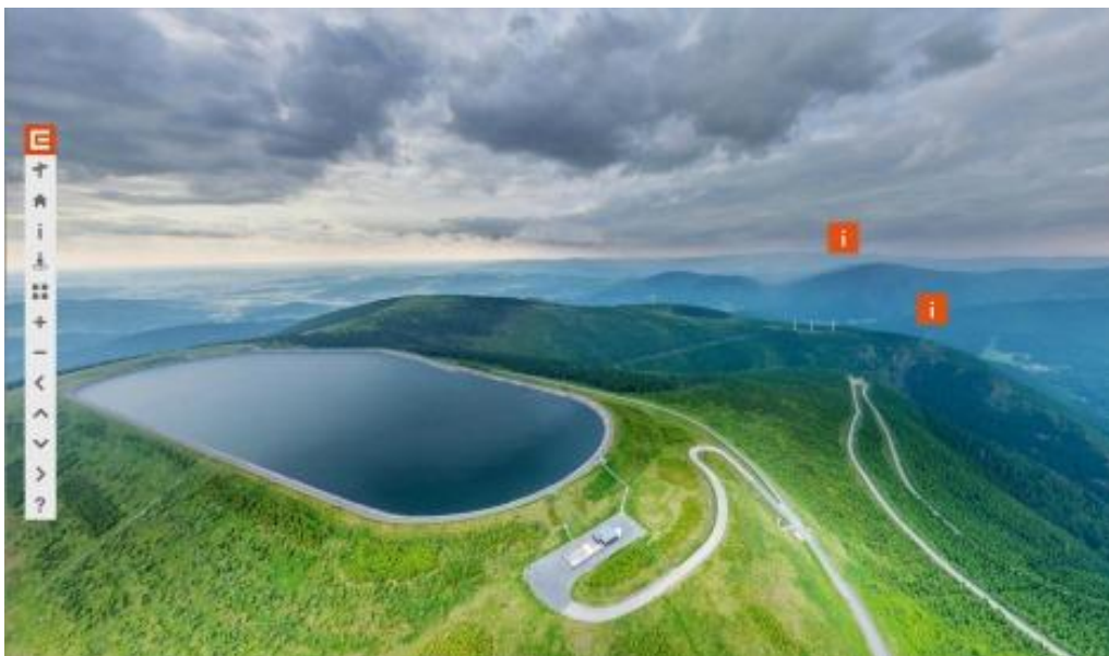
Obr. 4: Letecký pohled na horní nádrž
